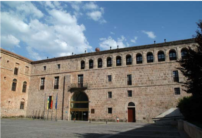
Fachada del Hotel en el Monasterio de Yuso
